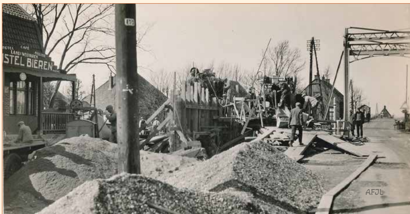
1936, basculebrug over de Damsloot met links daarnaast de werkzaamheden ten behoeve van de aanleg van een nieuwe stenen brug (collectie Regionaal Archief Alkmaar)
