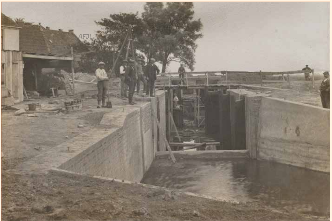
bouw van de nieuwe sluis met op de achtergrond de brug in de Westfrieseomringdijk (1920) (collectie Regionaal Archief Alkmaar)
