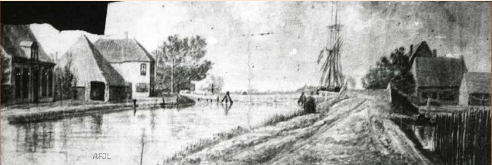
zeilschip wachtend voor de gesloten vlotbrug, links de notariswoning en 'Landswelveren' met doorrijstal, tekening Jan Vlam
