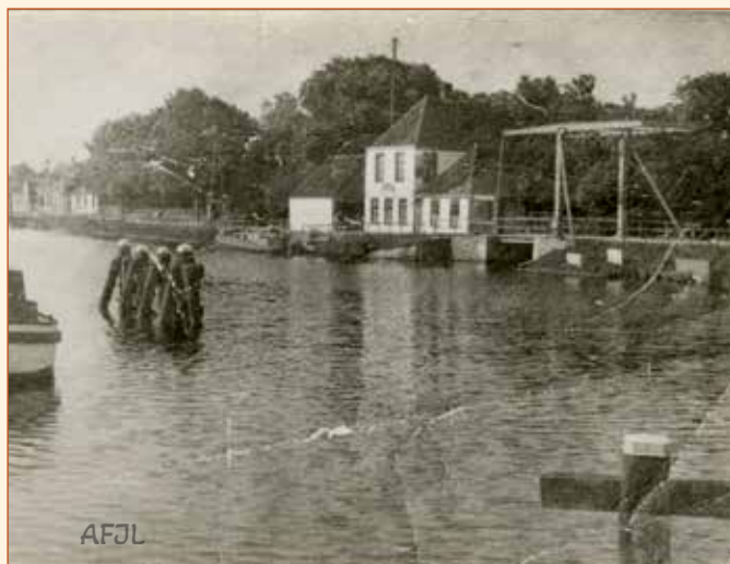
wipbrug over de Damsloot met 'Landswelveren'
