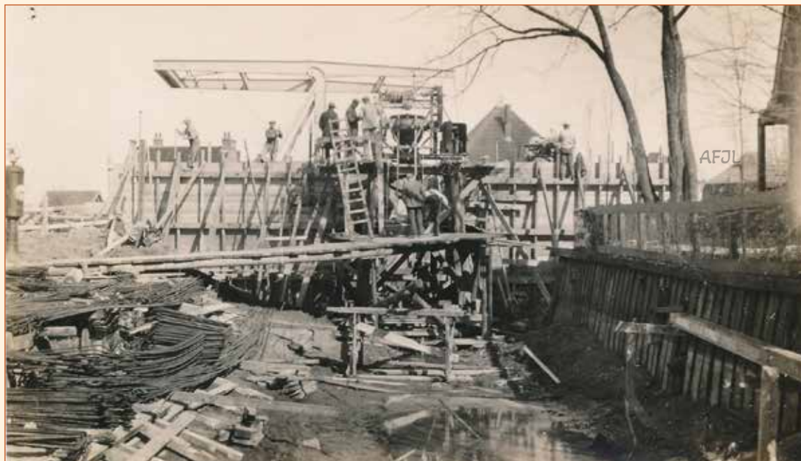
1936 werkzaamheden ten behoeve van de stenen brug ter vervanging van de basculebrug (collectie Regionaal Archief Alkmaar)
