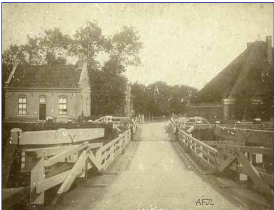
vlotbrug richting Sluisweg, links het brugwachtershuis
