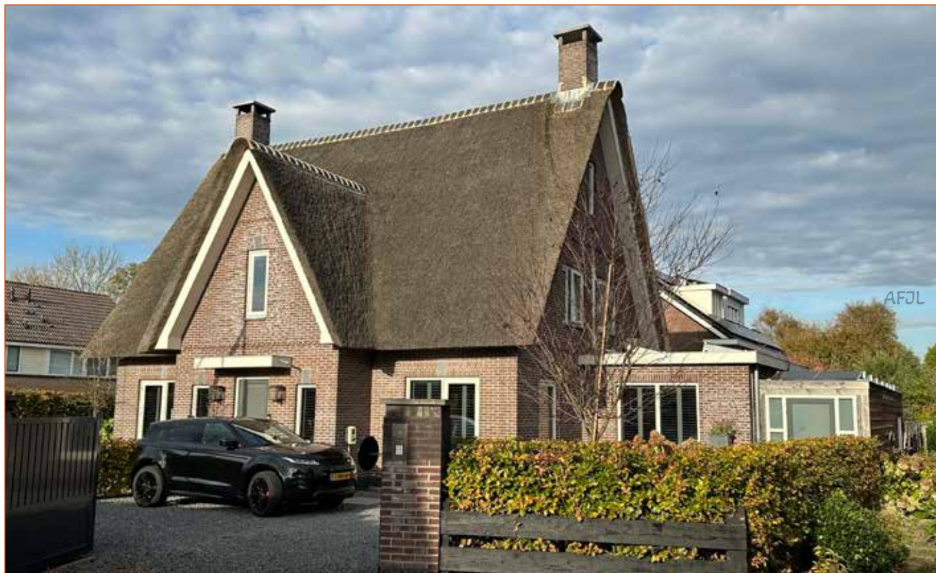
nieuwe woning Voorweg 118
