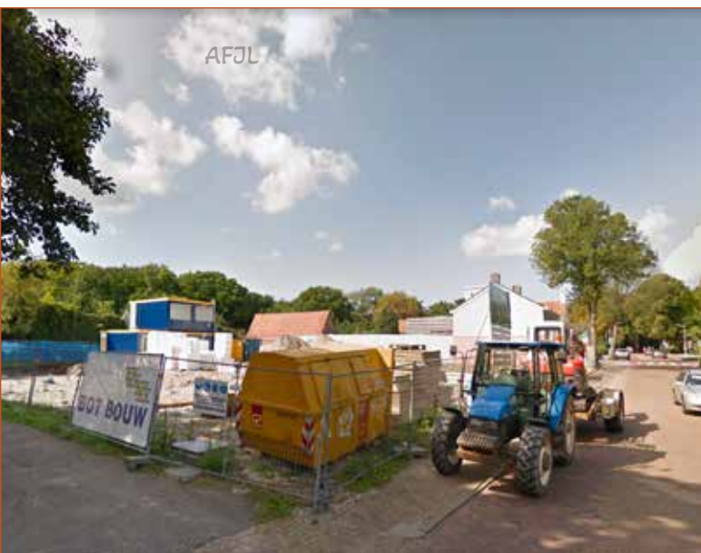
start van de bouw van de nieuwe woningen
