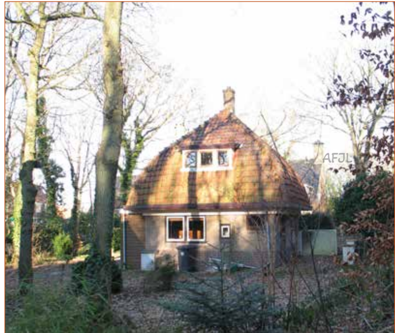
Hogenolweg 1, westelijke gevel
