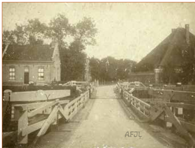
kijkje over de vlotbrug in de Sluisweg
