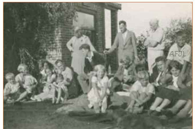
Oude Heereweg 2, families Onnes en Berman opname vanaf de overzijde van het Hargergat
