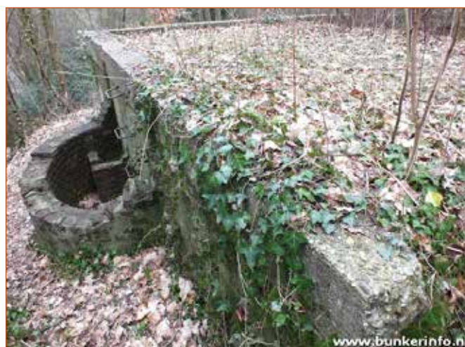
manschapenbunker achter bovenstaande manschapbunker (collectie WWW.Bunkerinfo.nl)
